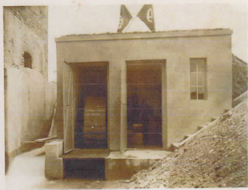
Das neue Wasserwerk von Puchheim.
