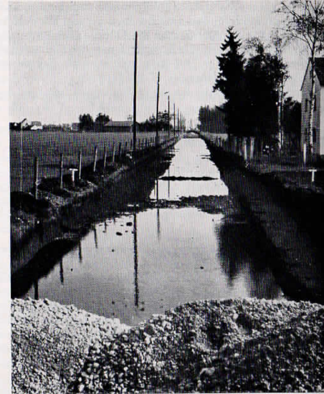
Straßenbau (Lochhauser Straße)
